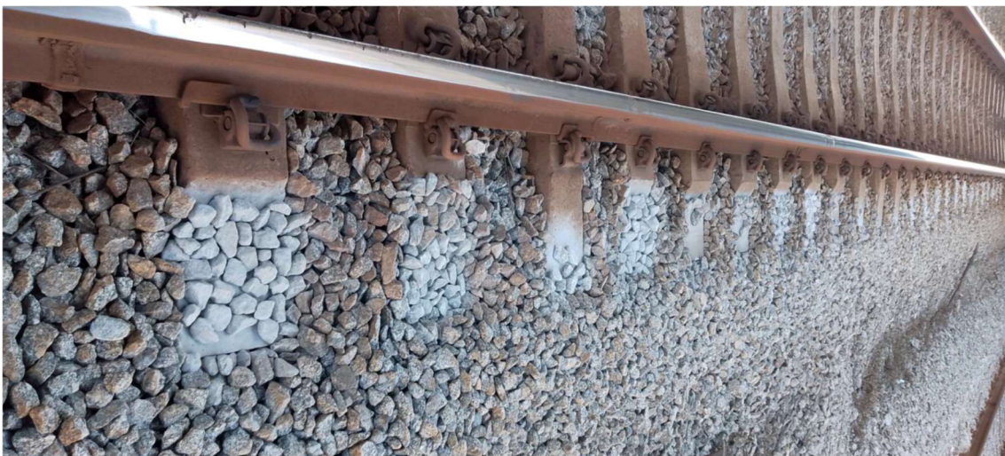
Figura 10 – solapamento de dormentes. Fonte: CPTM
