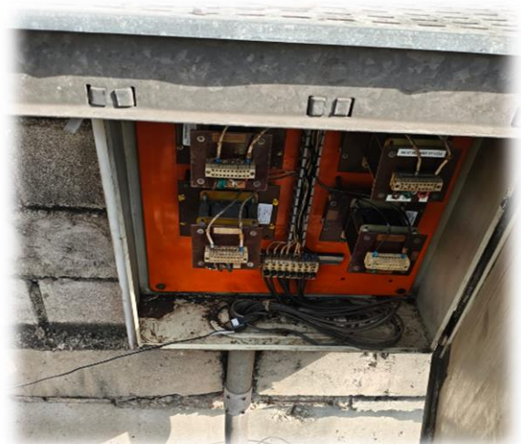
Figura 10 - Caixa shunt com transdutor.
