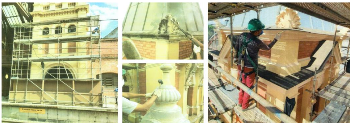
Figura 10 - Intervenções nos torreões: montagem de acessos, limpeza técnica, recomposição de ornamentos e acabamentos pictóricos. Fonte: Arquivo Sarasá (2022).
