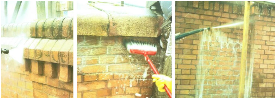
Figura 6 - Limpeza dos muros com detergente neutro. Fonte: Arquivo Sarasá (2022).
