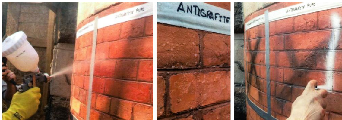
Figura 8 - Aplicação de hidrofugante antipichação e testes de penetração de spray. Fonte: Arquivo Sarasá (2022).
