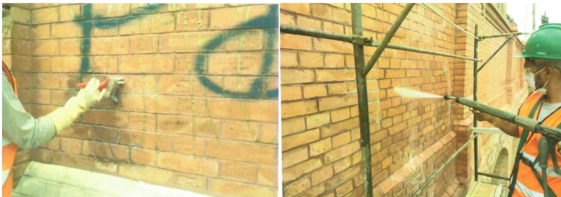
Figura 7 - Procedimento de remoção de pichações com removedor pastoso e limpeza com jateamento de água com pressão controlada. Fonte: Arquivo Sarasá (2022).
