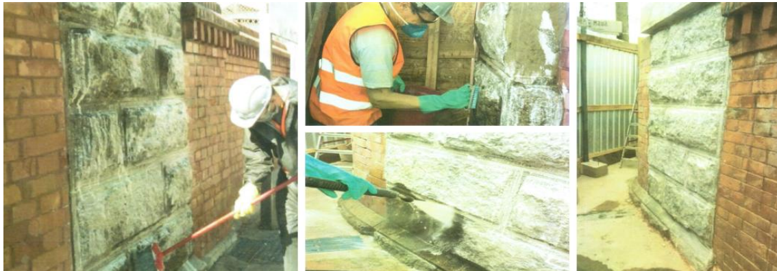
Figura 9 - Cantarias, aplicação de removedor pastoso e jateamento com garnet. Fonte: Arquivo Sarasá (2022).
