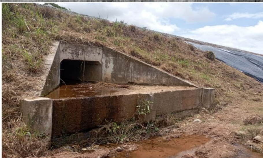
Figura 11 – Perfil de 400 MHz GSSI selecionado no km 673, mostrando a repetição da alteração central e das zonas de maior umidade em diferentes posições da via. Abaixo, a galeria onde supostamente havia vazamento de fluidos no sublastro da ferrovia.
