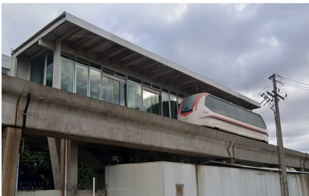
Figura 2 – Vista da Fachada da Estação ATR - Aeromovel. Fonte: Google
