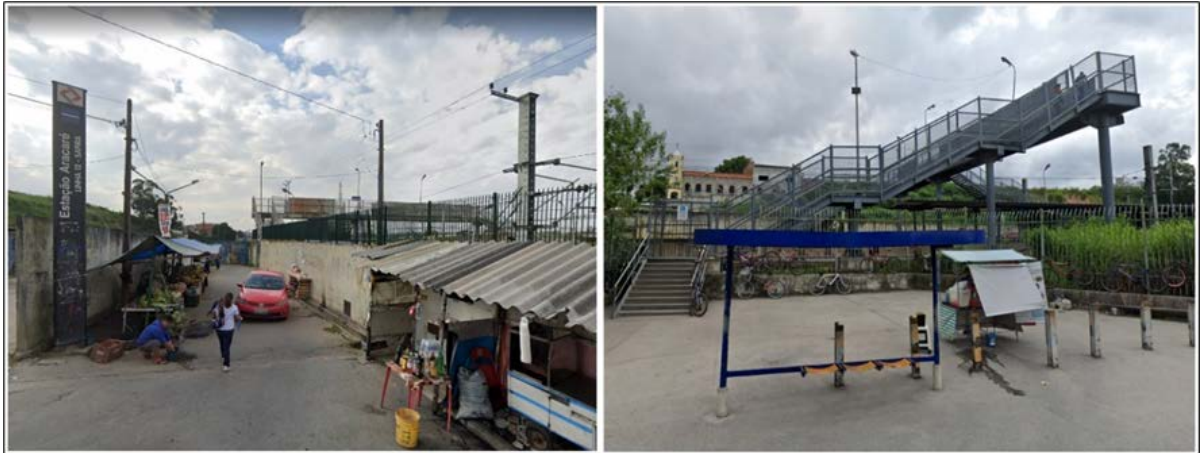
Figura 3 - Estação Aracaré – Acesso leste (esq.) e acesso oeste (dir.). Fonte: Acervo CPTM.
