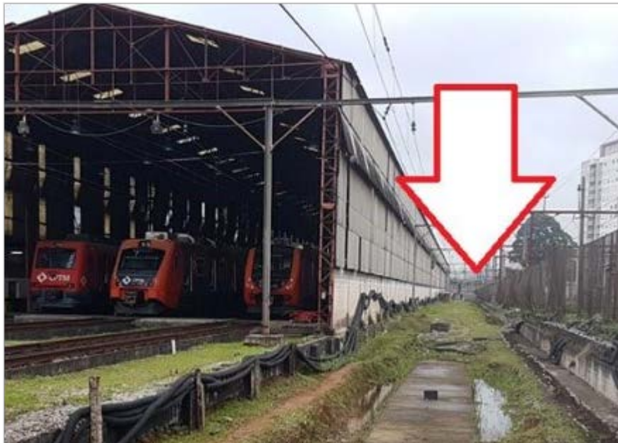
Figura 10: Vista do local pretendido para a implantação da vala de sopramento. Fonte: Acervo CPTM.
