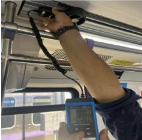
Figura 14 – Medição da velocidade do ar insuflado em trem da Frota P (Linha 5). Fonte: Autor
