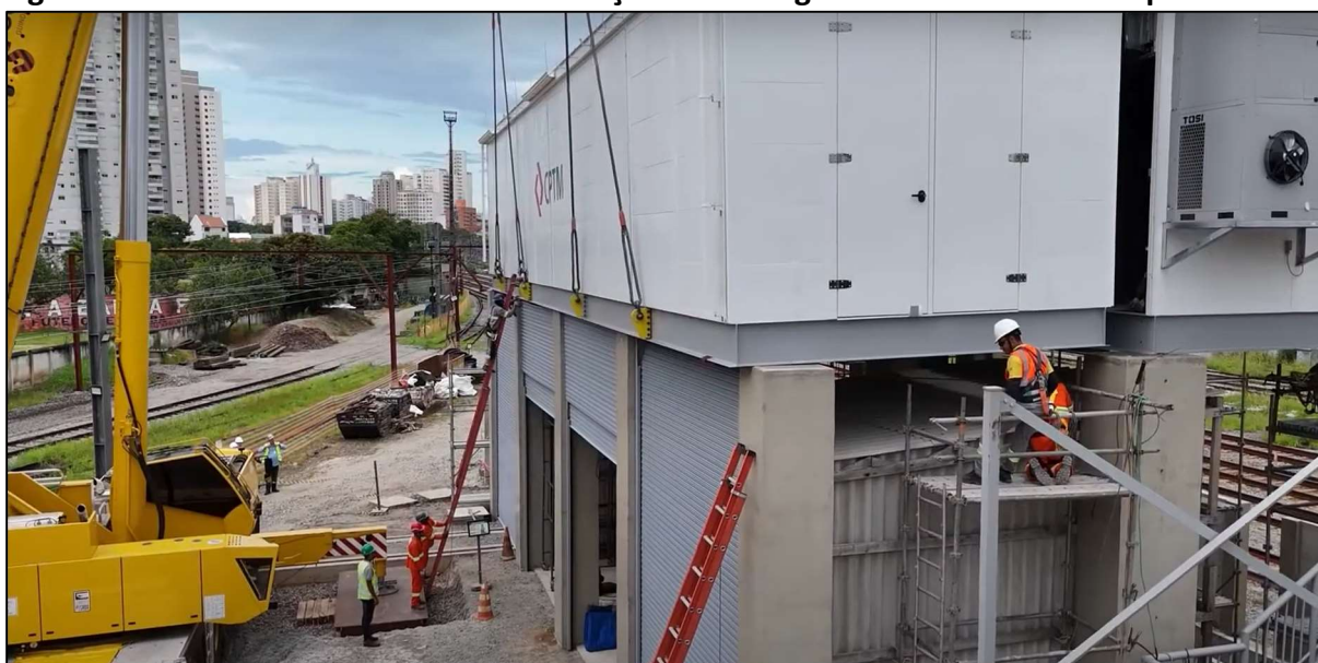
Figura 18 – Posicionamento e fixação do segundo módulo nos pilares
