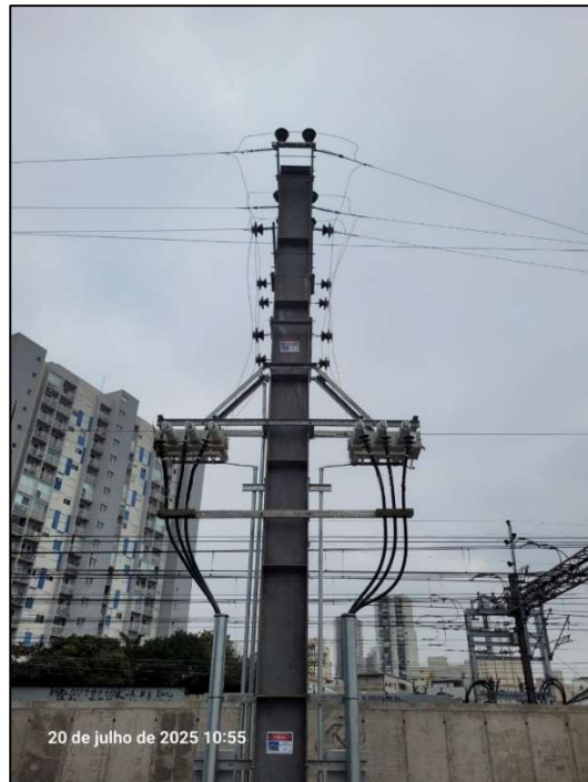
Figura 20 – Postes de interligação às Linhas de 34,5kV
