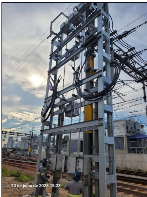
Figura 22 – Pórticos de interligação com a Rede Aérea de tração (3kVcc)
