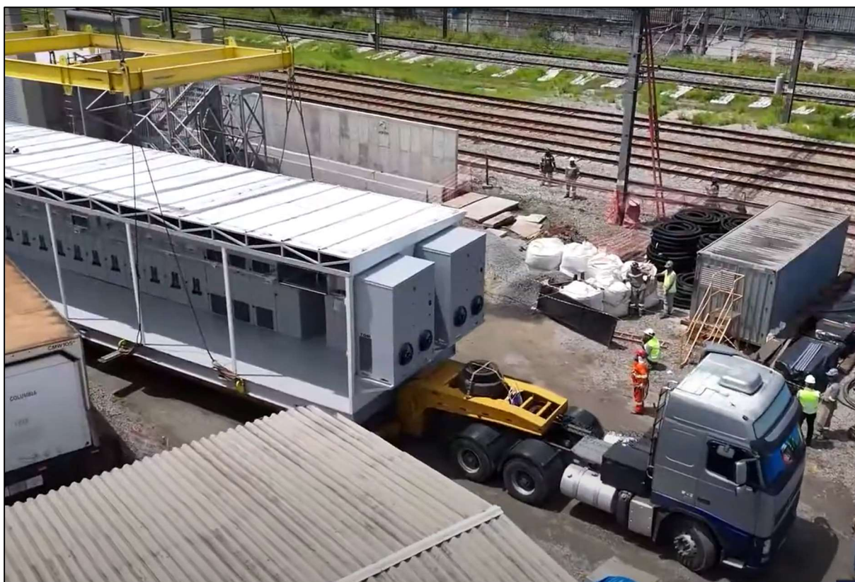
Figura 14 – Carreta com um dos módulos preparada para içamento
