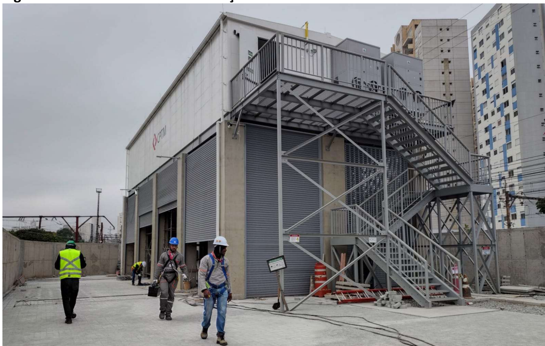
Figura 2 – Vista externa da subestação Memorial da América Latina
