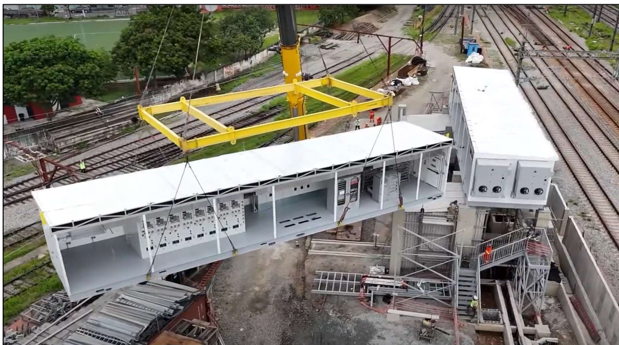
Figura 17 – Posicionamento e fixação do segundo módulo nos pilares
