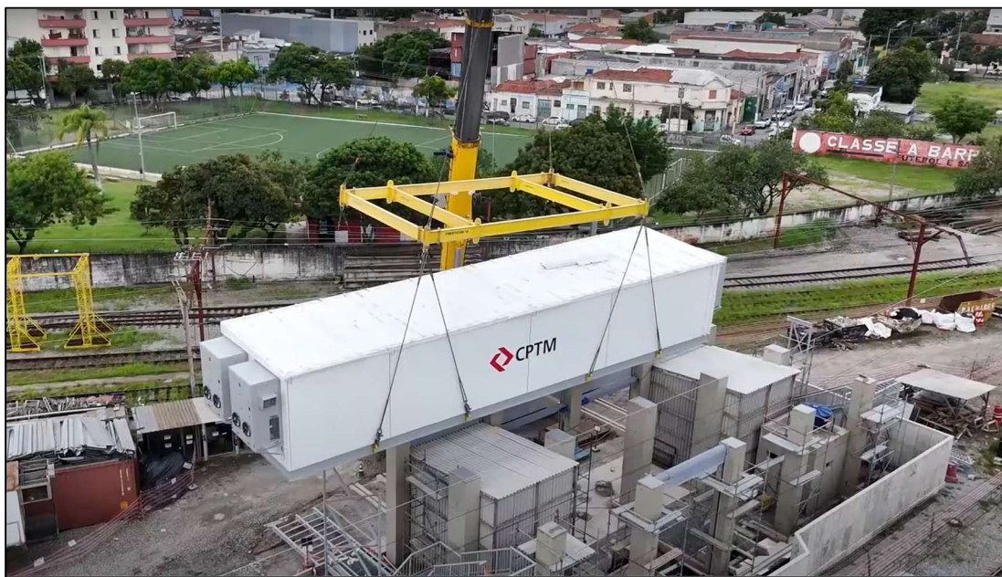
Figura 15 – Carreta com um dos módulos preparada para içamento
