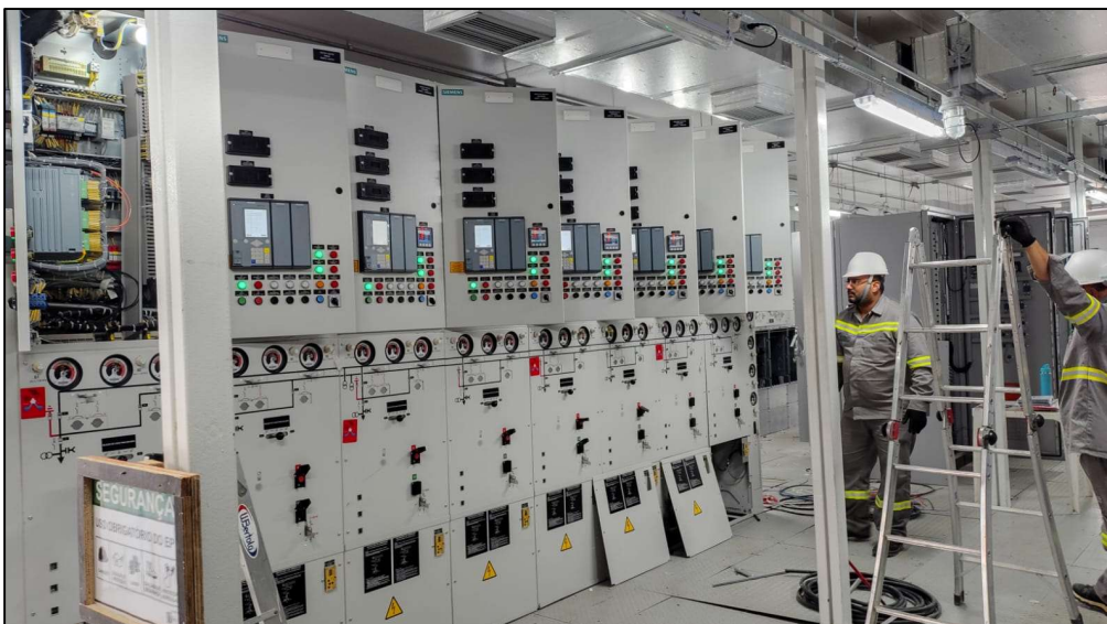
Figura 26 – Pré-comissionamento dos Conjuntos de Manobra e Controle (CMC's)
