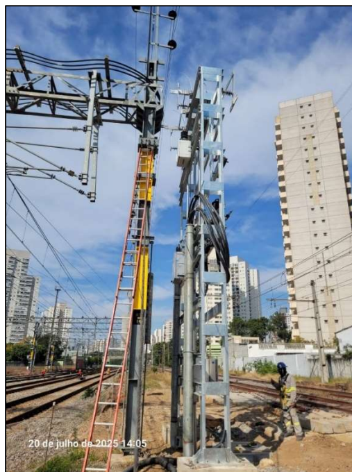
Figura 22 – Pórticos de interligação com a Rede Aérea de tração (3kVcc)
