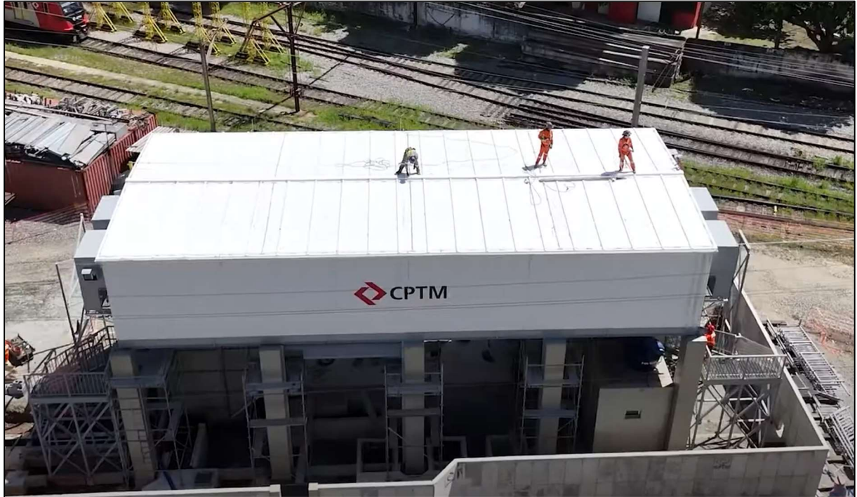
Figura 19 – Ajustes finais após fixação dos dois módulos do eletrocentro nos pilares
