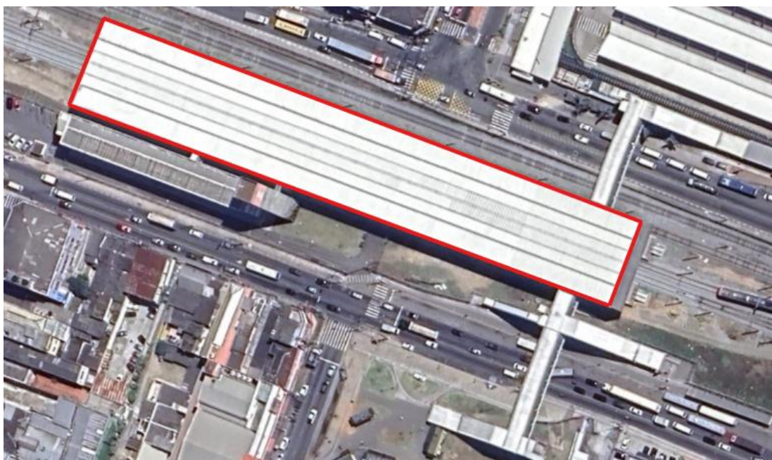
Figura 5 - Vista aérea da estação Suzano. Fonte: Google Earth, 2024
