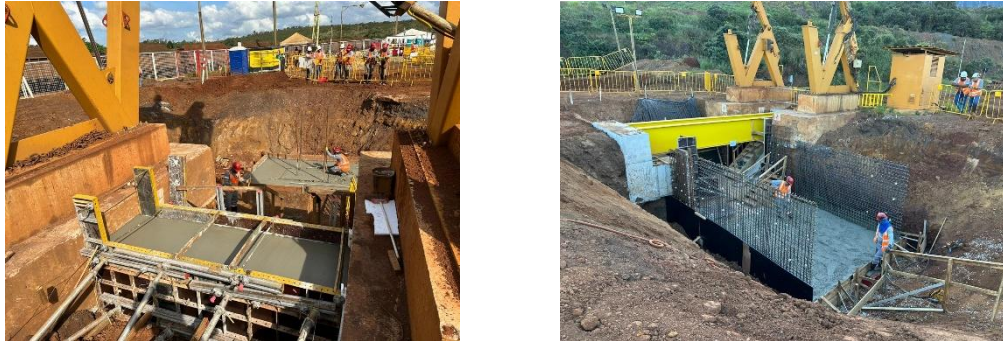
Figura 13 – Instalação da base para implantação do Formatador. Fonte: Vale
