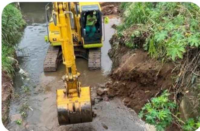
Figura 6 - Limpeza e desassoreamento do leito do rio
