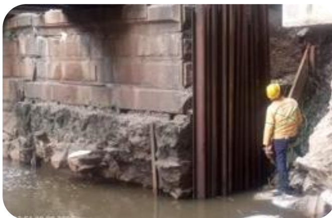
Figura 5 - Cravação de trilhos nos blocos de apoio da ponte
