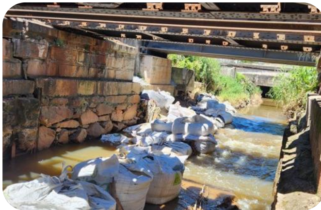
Figura 4 - Execução de enscadeira para possibilitar o acesso e a intervenção na fundação
