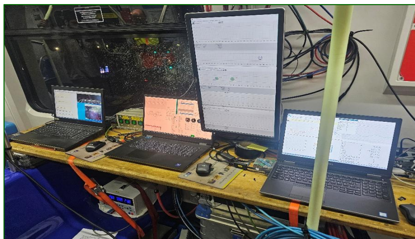
Figura 15 - Instalações dentro do salão da composição. Fonte: Relatório de medição
