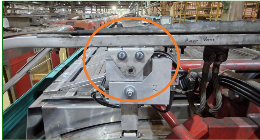
Figura 8 - Sistema para medição de elevação. Fonte: Relatório de medição
