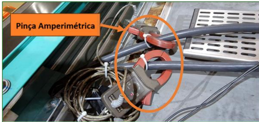
Figura 6 - Pinça amperimétrica. Fonte: Relatório de medição
