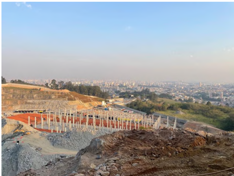
Imagem 3 – Avanço da obra (Agosto/2022)
