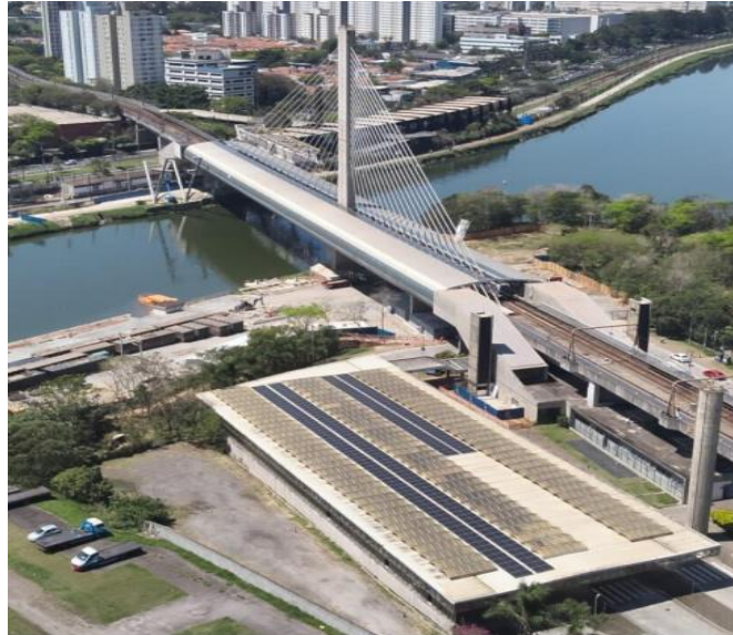
Figura 1. Imagem do Sistema Instalado.
