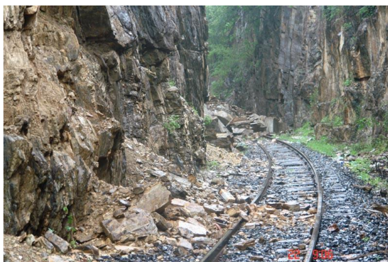
Figura 3 – Queda de blocos em trecho ferroviário entre Urandi/MG e Licínio de Almeida/BA. Fonte: Theo Filho (UrandiNews, 2013)
