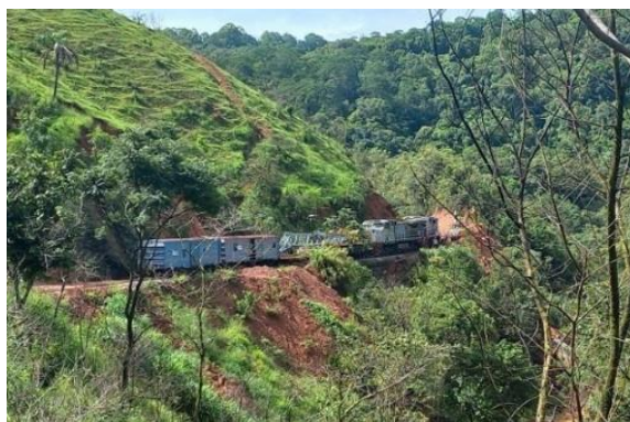
Figura 4 – Evidências de rastejo à montante da linha férrea em Campos Altos/MG na porção superior esquerda. Fonte: Samuel Duna, Wikiloc, 2023.
