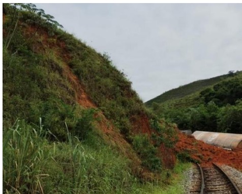
Figura 2 - Deslizamento de terra registrado em Quatis/RJ em fevereiro de 2023. Fonte: Jornal O Dia
