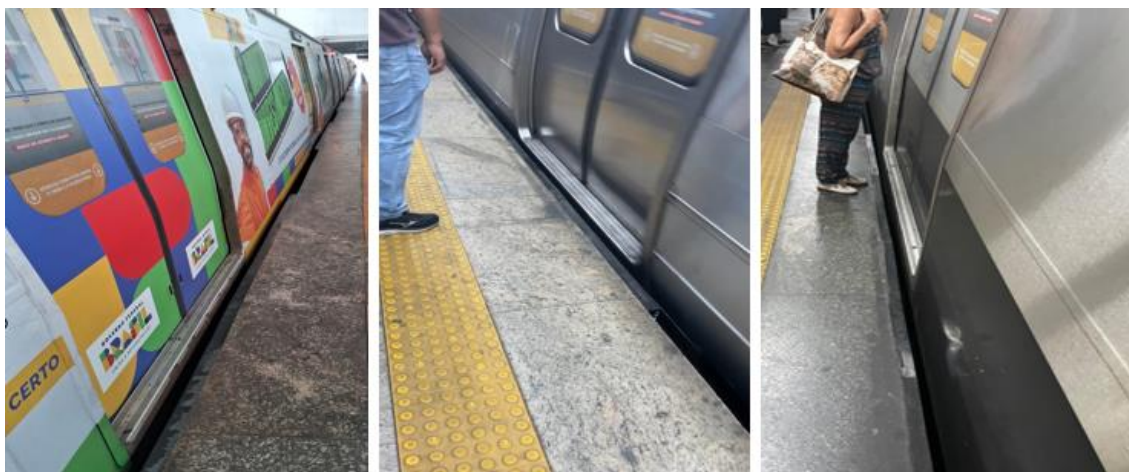
Figura 10 – Gap fillers instalados nas estações Maracanã, Cardeal Arcoverde e Largo do Machado.
