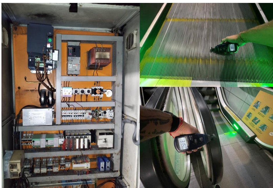
Figura 22 – Ajuste de velocidade no quadro de comando e aferição de velocidade posterior.
