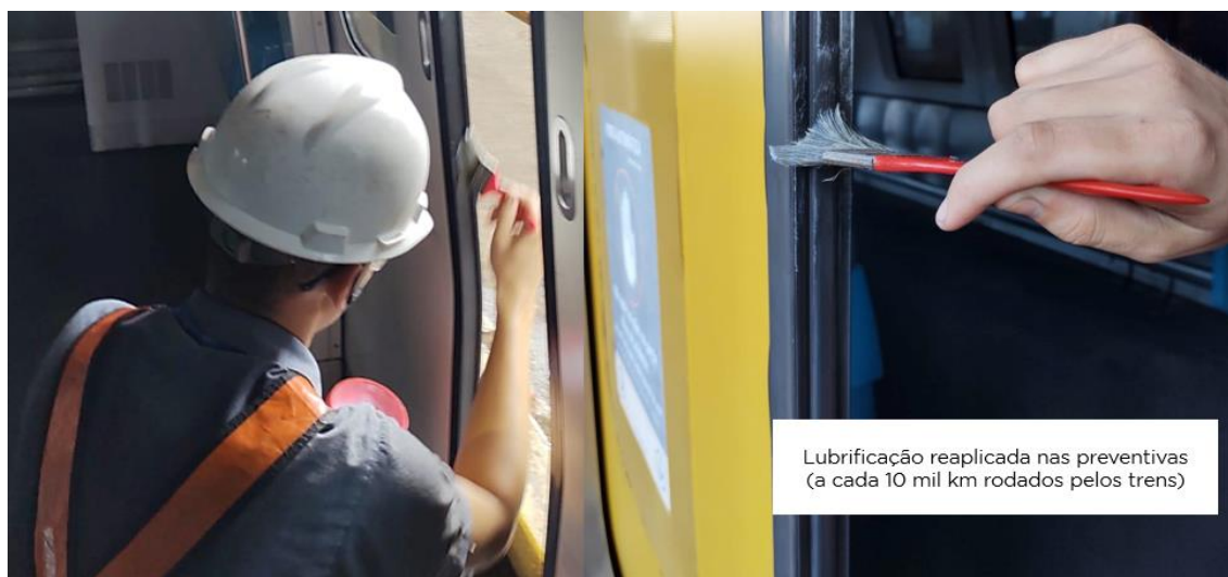
Figura 17 – Aplicação de graxa nas borrachas da porta.
