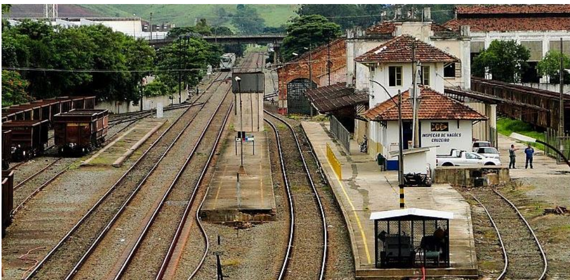
Figura 14 – Pátio de estação ferroviária e gare.
