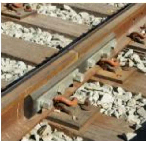
Figura 1- JIC instalada em via férrea
