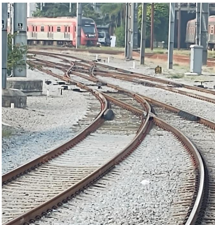
Figura 6 – Conjunto de AMV do “X”, e curvas adjacentes
