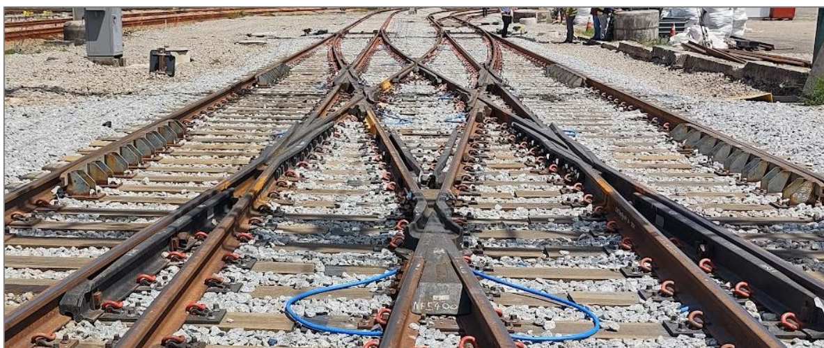
Figura 12 – Região central do “X”, com todos os componentes já instalados
