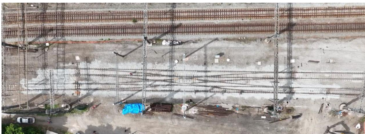
Figura 11 – Alteração do X do Brás em execução
