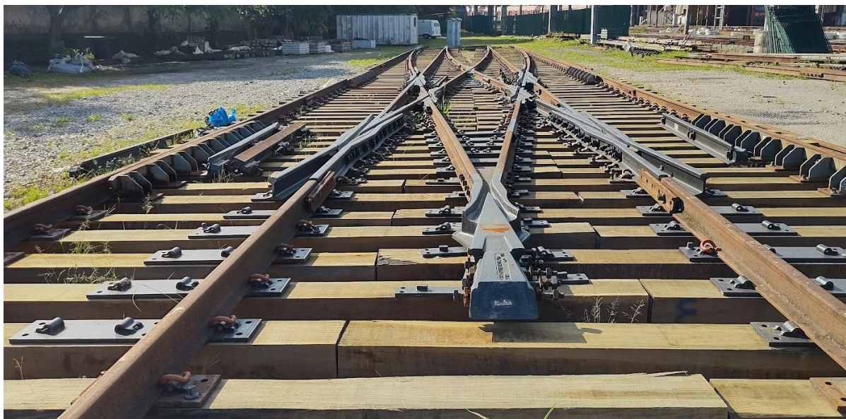
Figura 9 - Conjunto do “X” na fase de pré-montagem
