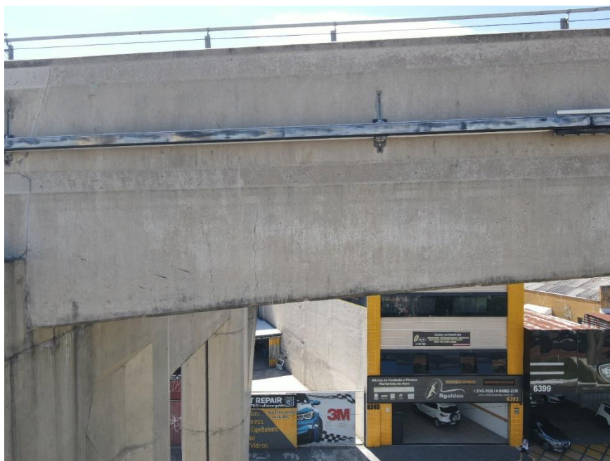
Figura 15 – Aproximação do drone com a via energizada Fonte: IPT/Metrô-SP, 2024
