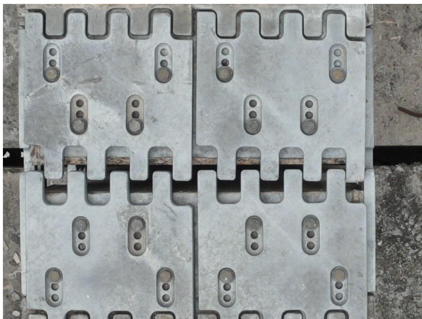
Figura 12 – Teste de inspeção de finger plates na Linha 17 Fonte: IPT/Metrô-SP
