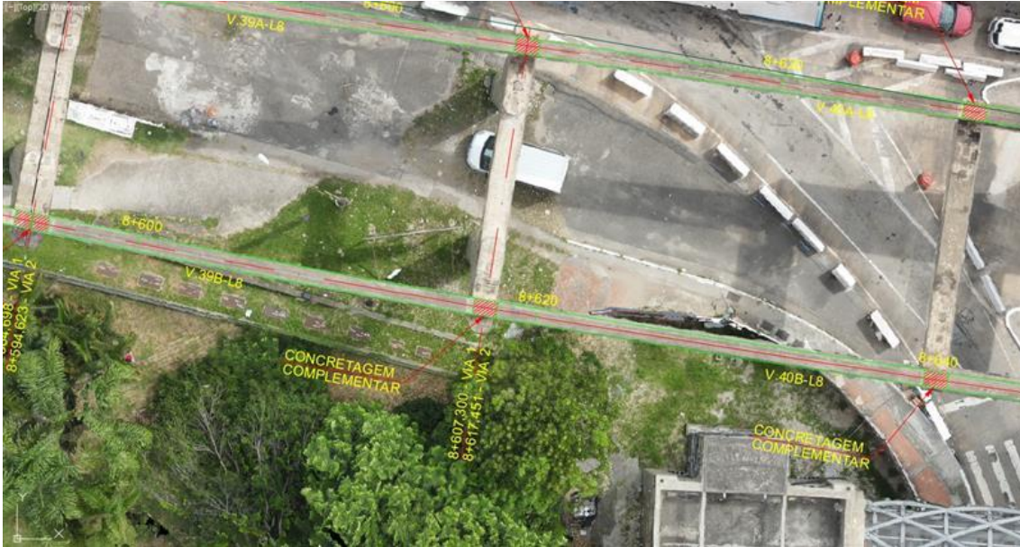
Figura 24 – Aproximação de ortomosaico gerado na Linha 17 - Ouro Fonte: IPT/Metrô-SP, 2024
