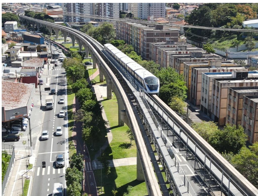
Figura 13 – Teste do drone em trecho de via energizada e próximo à rede de alta tensão Fonte: IPT/Metrô-SP, 2024
