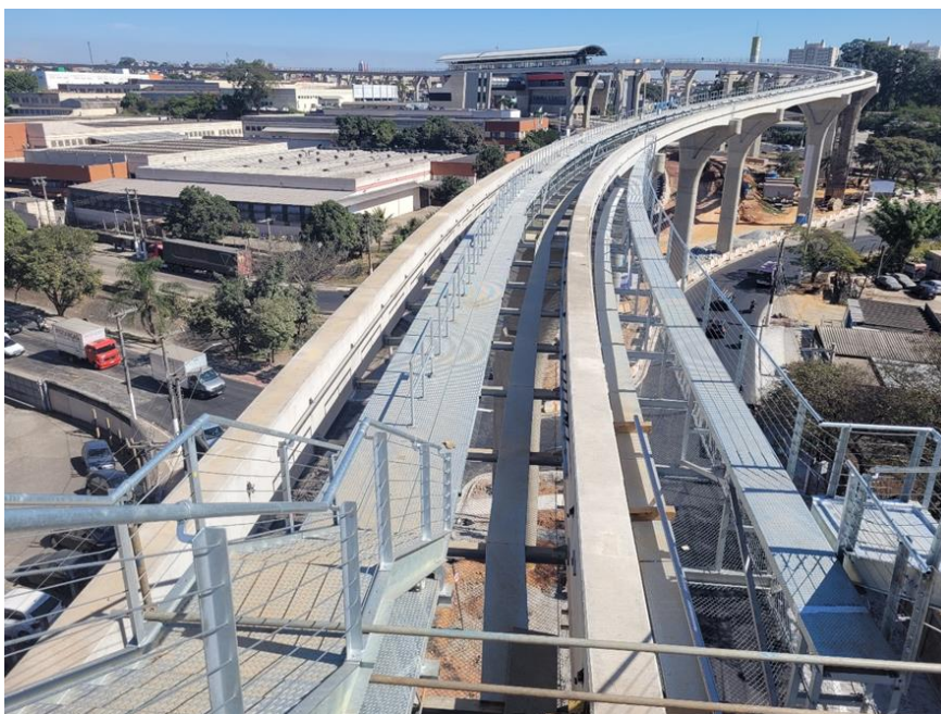
Figura 1 – Vista geral de parte do monotrilho da Linha 15 - Prata Fonte: Metrô-SP, 2023
