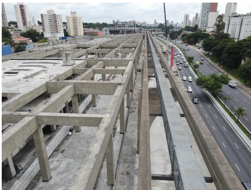
Figura 2 – Vista geral de parte do monotrilho da Linha 17 - Ouro Fonte: IPT/Metrô-SP, 2024
