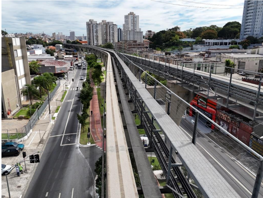
Figura 14 – Aproximação do drone da via energizada Fonte: IPT/Metrô-SP, 2024
