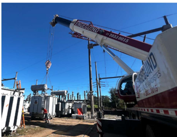
Figura 4 - Movimentação dos transformadores
