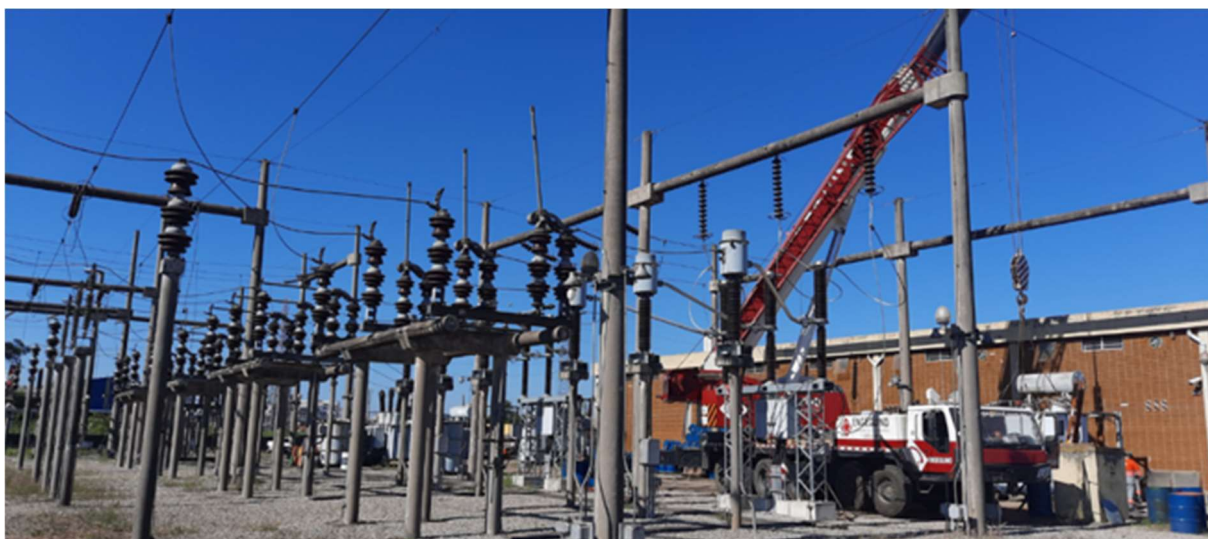
Figura 5 - Posicionamento final do transformador
