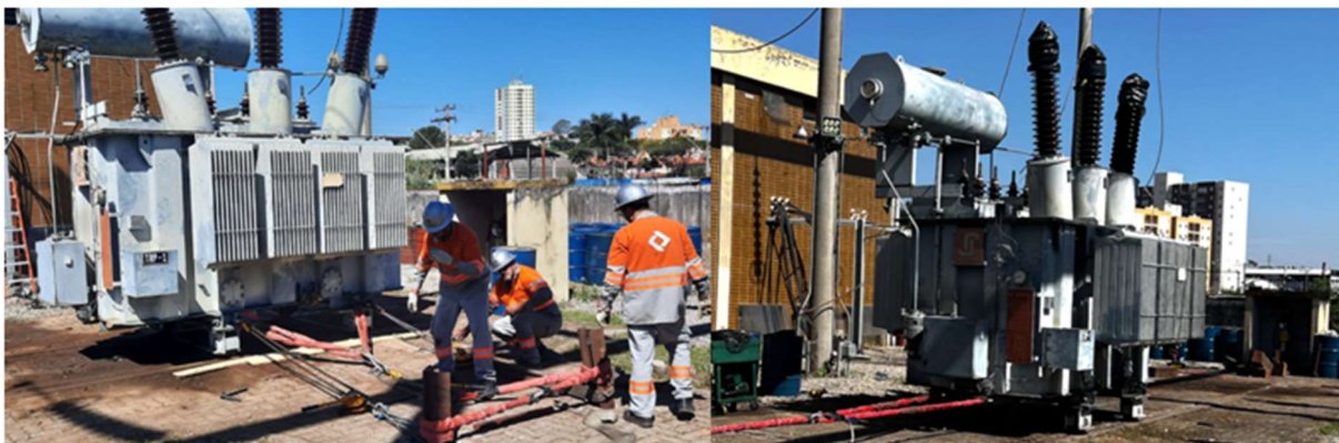
Figura 2 - Movimentação do transformador avariado
