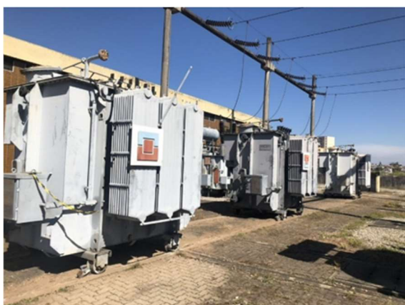
Figura 1 – Transformadores sobressalentes
