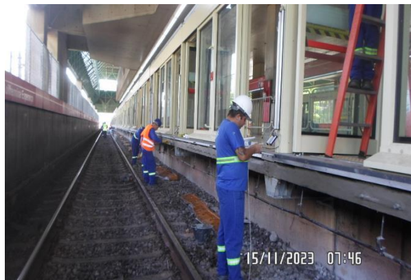
Figura 15 - Reforço de plataforma com braço metálico
