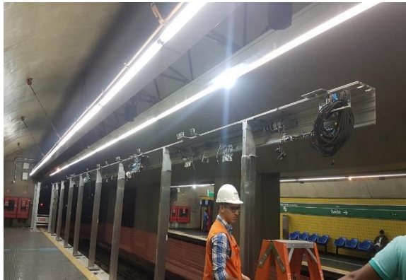
Figura 4 – Montagem de PSD não modular
