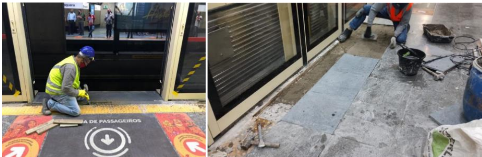
Figura 31 - Acabamento e harmonização do piso da plataforma da estação Jabaquara
