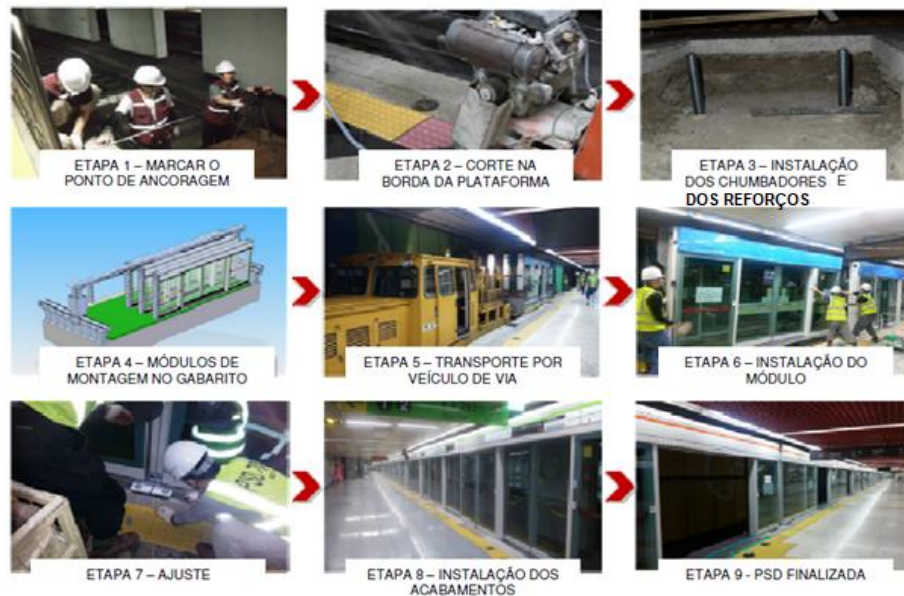
Figura 23 - Visão geral da instalação do Módulo PSD
