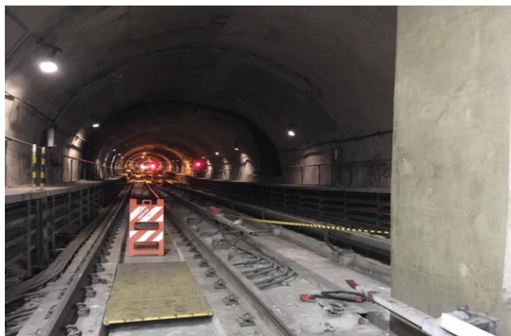
Figura 35 - Interdição de via e convivência com a operação comercial na estação Vila Madalena
