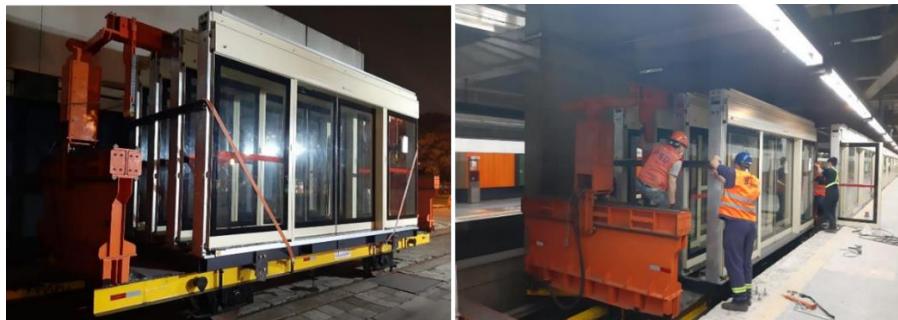
Figura 33 - Vagoneta de transporte e instalação de módulos de PSD
