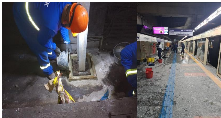
Figura 25 - Obra civil de preparação da plataforma da estação Tucuruvi
