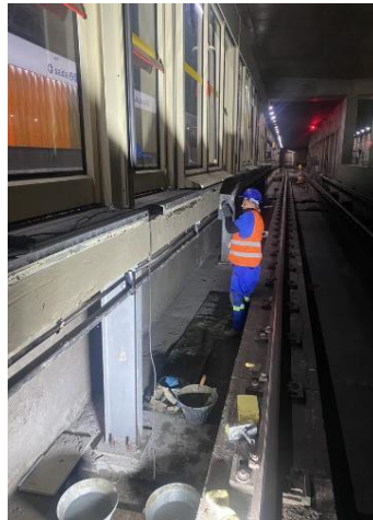
Figura 14 - Reforço de plataforma com pilarete
