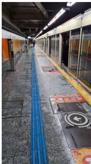
Figura 38 - Fachada da estação Jabaquara após montagem
