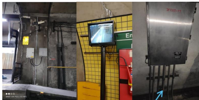
Figura 24 - Remoção de interferências
