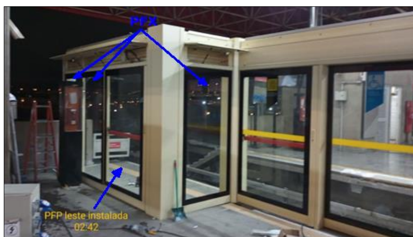
Figura 2 – Porta de final de plataforma (PFP) e painel fixo (PFX) em instalação
