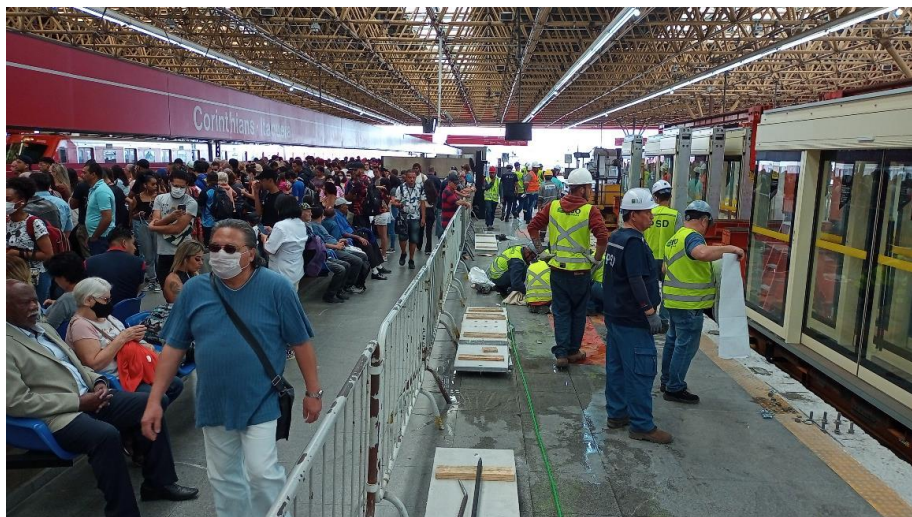
Figura 26 - Preparação do piso de uma das plataformas da estação Corinthians Itaquera
