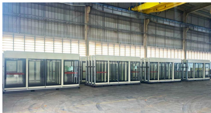
Figura 20 - Módulos Típicos posicionados após a pré-montagem
