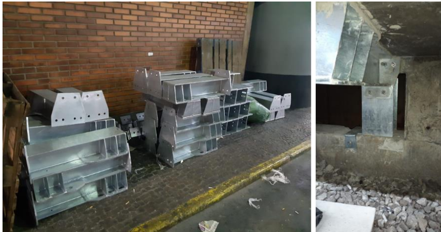
Figura 29 - Instalação de braços metálicos na estação Corinthians Itaquera
