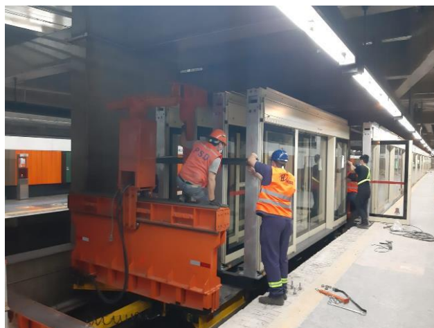
Figura 5 – Transporte e montagem de PSD modular na estação Jabaquara
