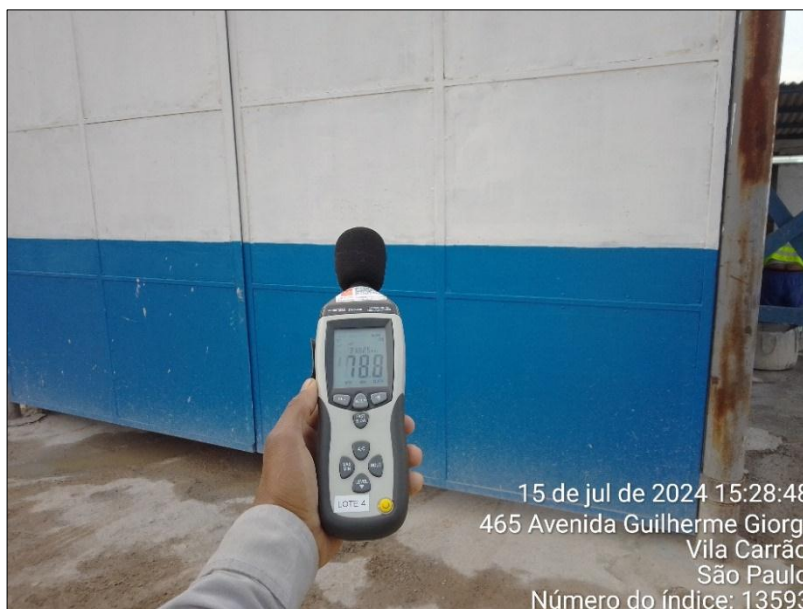
Foto 6 – Medição de ruído após o enclausuramento (crédito imagem Equipe Engenharia ambiental lote 05).
