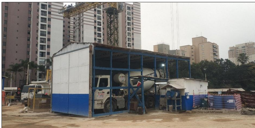
Foto 4 – Enclausuramento da betoneira para mitigação de ruído solução complementada com a colocação de portão, destaque ao fundo para os edifícios da Av. Guilherme Giorgi.
