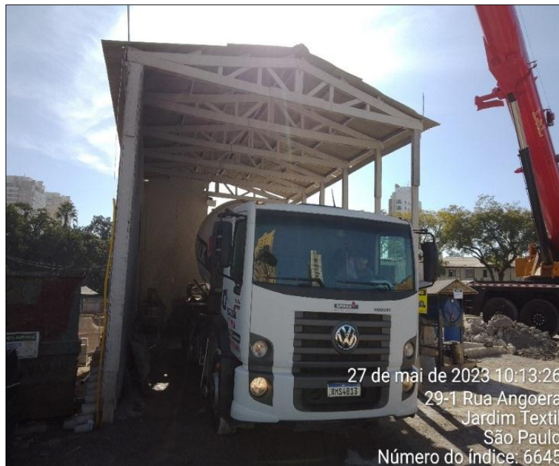
Foto 2 – Enclausuramento da betoneira para mitigação de ruído, solução realizada pela engenharia civil – Solução 1, sem o portão.
