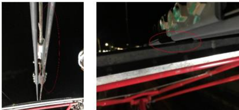
Figura 25 - Ajustes no nivelamento dos fios de contato
