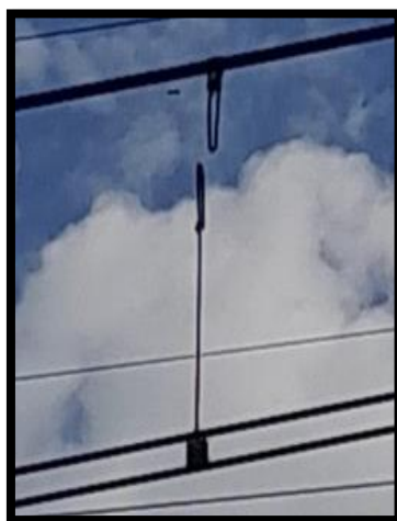
Figura 17 - Suspensório modelo antigo rompido
