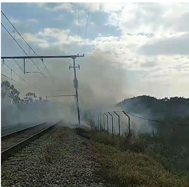
Figura 10 – Fumaça de incêndio cobrindo parcialmente a visibilidade da via férrea. (Fonte: foto dos autores)
