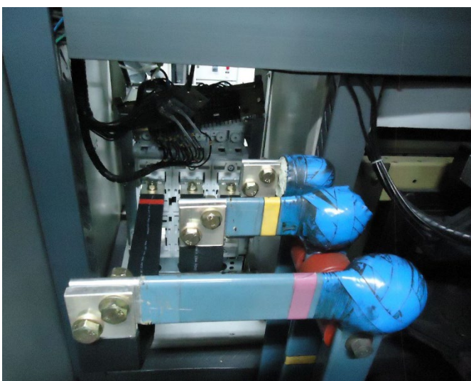
Figura 9 – Detalhe da substituição dos barramentos de entrada (capa na cor preta) do novo disjuntor SIEMENS 3WL
