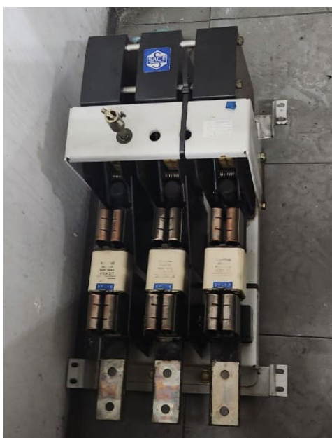
Figura 13 – QDGF: Detalhe da seccionadora antiga, SACE Bergamo, de 800 amperes, já removida do quadro QDGF 460VCA
