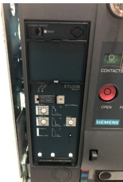
Figura 11 – Vista frontal da nova unidade de proteção microprocessada (ETU) do disjuntor Siemens, modelo 3WL
