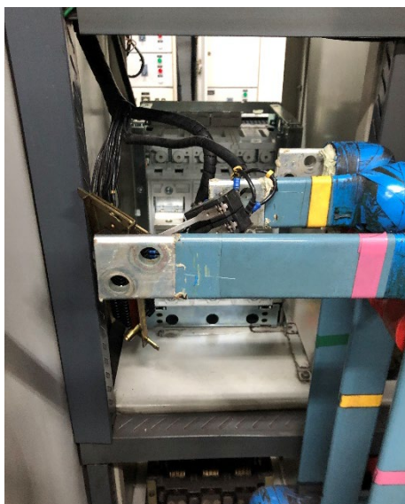
Figura 12 – Detalhe da retirada dos barramentos antigos durante modernização (novo disjuntor SIEMENS 3WL 800 A) - vista da parte traseira
