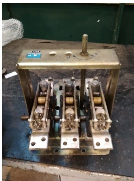
Figura 13 – QDGF: Detalhe da seccionadora antiga, SACE Bergamo, de 800 amperes, já removida do quadro QDGF 460VCA
