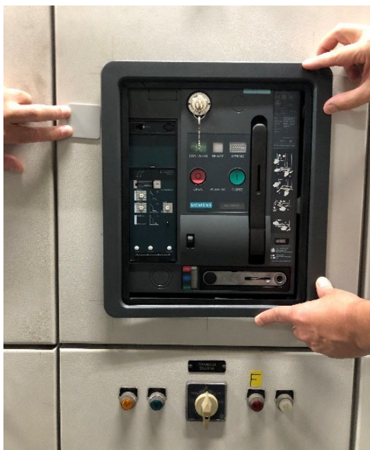
Figura 10 – Detalhe da modernização (novo disjuntor SIEMENS 3WL 800 A) instalado no seu compartimento/cela, bem como a finalização do acabamento frontal na porta da cela/compartimento
