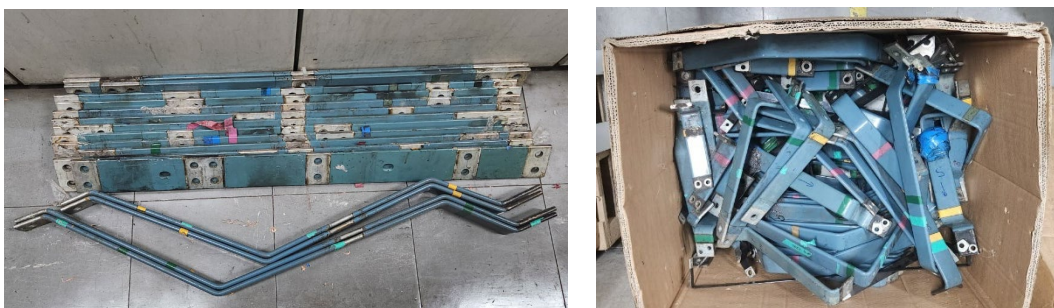
Figura 35 – Barramentos de distribuição antigos (QPD) que foram substituídos por novos
