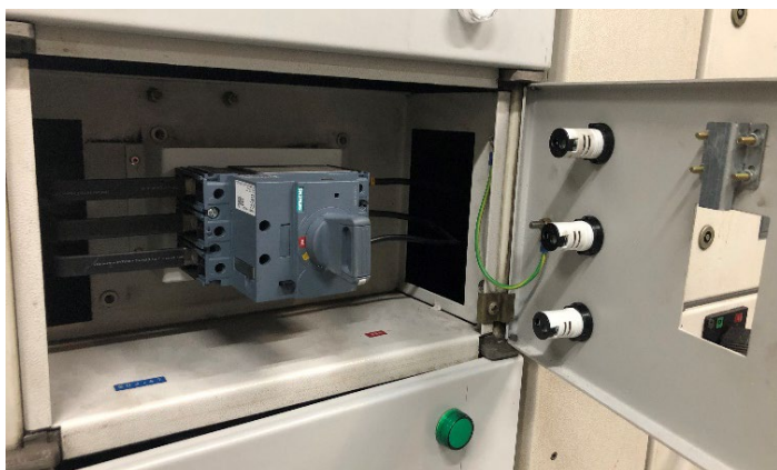
Figura 16 – QDGF: Vista interna da modernização (nova gaveta com disjuntor caixa moldada SIEMENS modelo 3VM) no seu compartimento/cela
