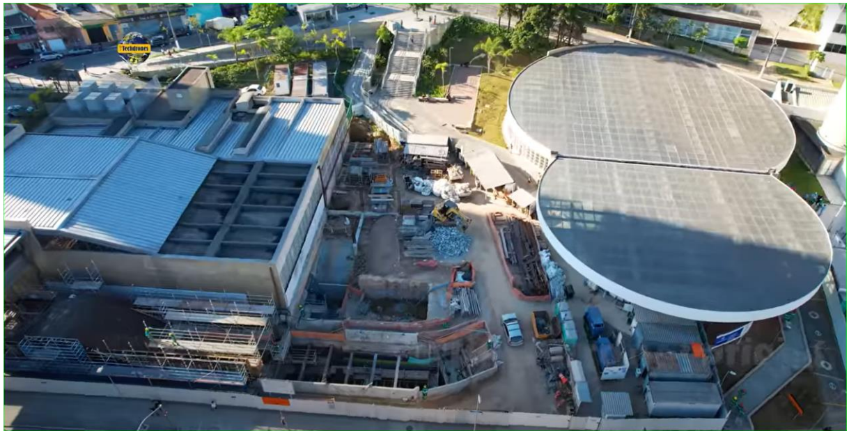
Figura 25: Intervenções em execução e já executadas na estação Vila Prudente da Linha 2 e na integração com a Linha 15 (junho/2023).
