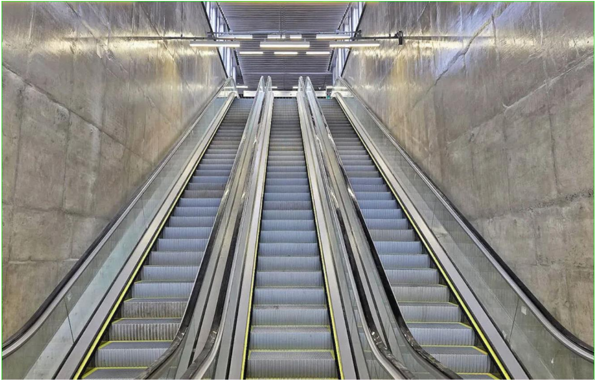
Figura 26: Novas escadas rolantes na integração entre as linhas 2 e 15.
