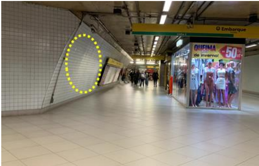
Figura 23: Desemboque do novo túnel na estação Paulista da Linha 4 – Amarela
