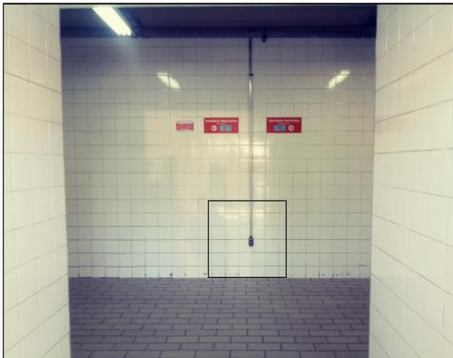
Figura 8 – Entrada do Banheiro público – Estação Calmon Viana.
