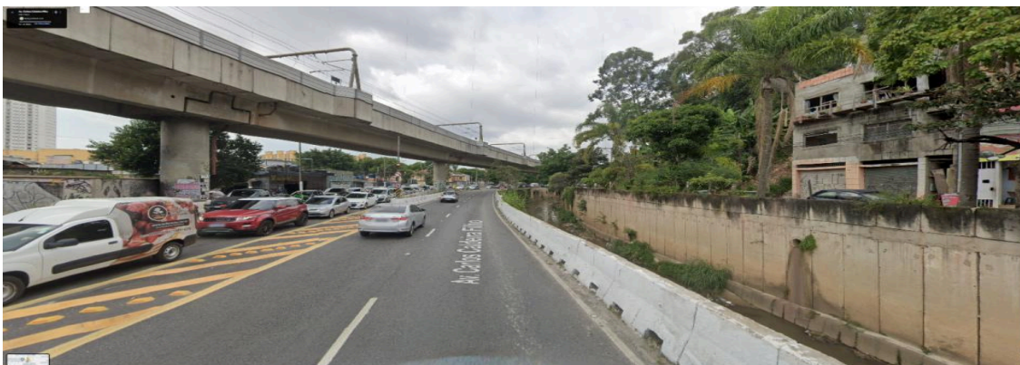
Fig 24. Semelhante à L5 Lilás Metrô, tangenciando a Av. Carlos Caldeira e córrego.[15]
