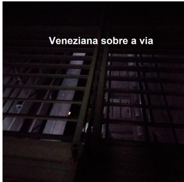
**Figura 1 – Veneziana sobre a via, trecho DEO-BFU, para o poço de alívio Oeste**
