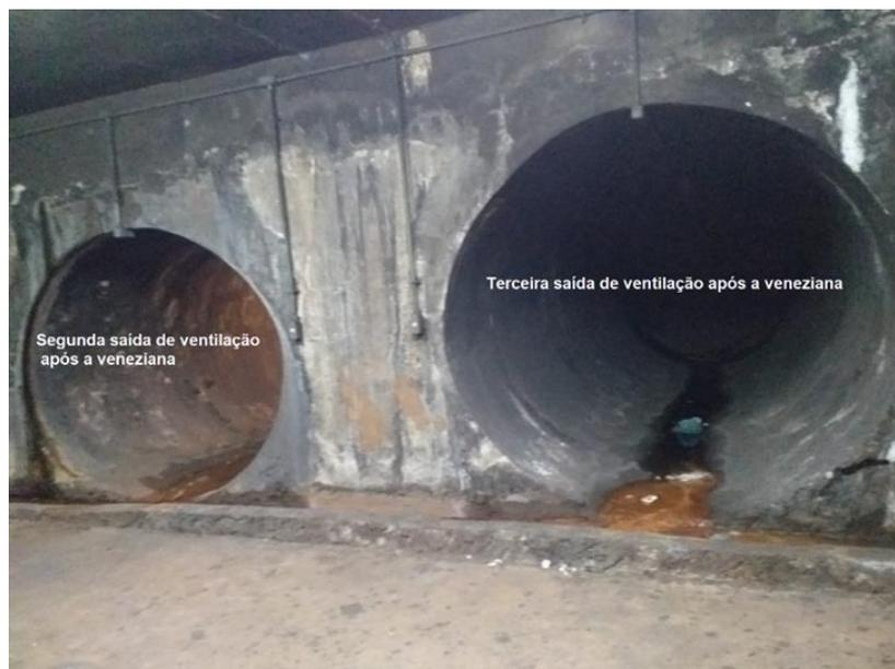
**Figura 2 – Saídas de ventilação após as venezianas**
