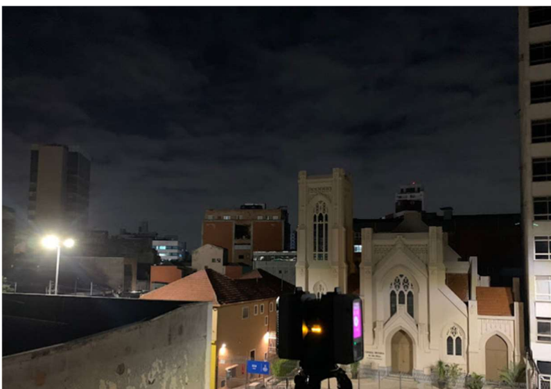
Figura 26- Trabalho noturno (Foto acervo Metrô/CDT)
