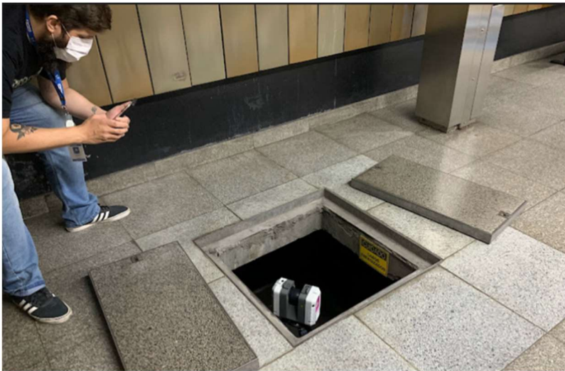
Figura 25- Ambiente Confinado (Foto acervo Metrô/CDT)
