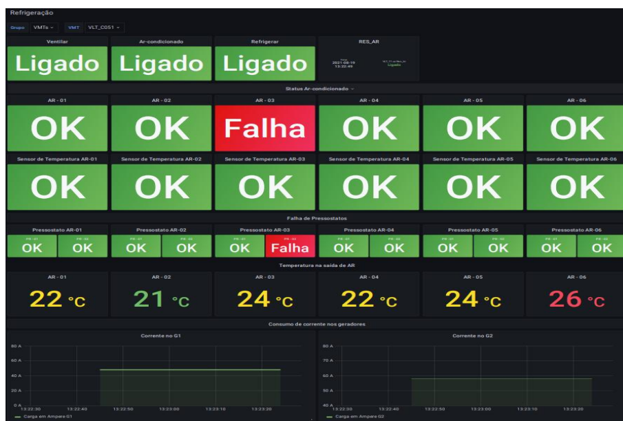
Figura 10 - Status de funcionamento do sistema de climatização.
