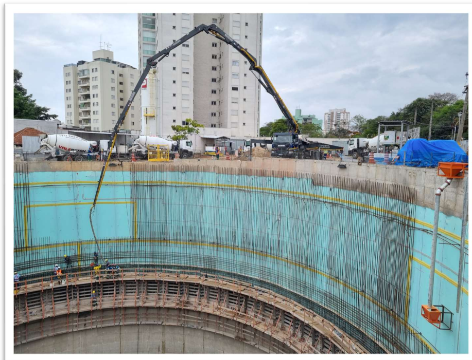
Foto 6 – Concretagem das paredes de revestimento secundário da Estação Vila
