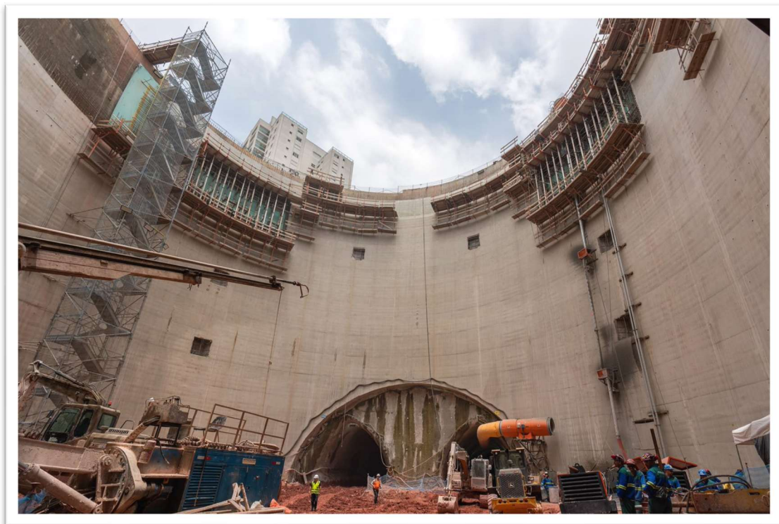
Foto 17 – Aparência e qualidade de concretagem das paredes da Estação Vila Formosa
