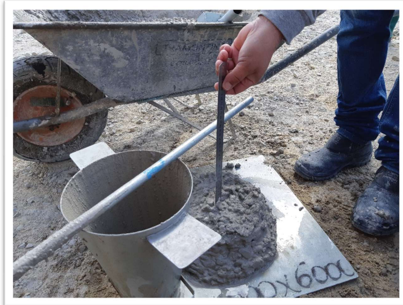
Foto 7 – Aferição da consistência do concreto (slump test) - Estação Vila Formosa
