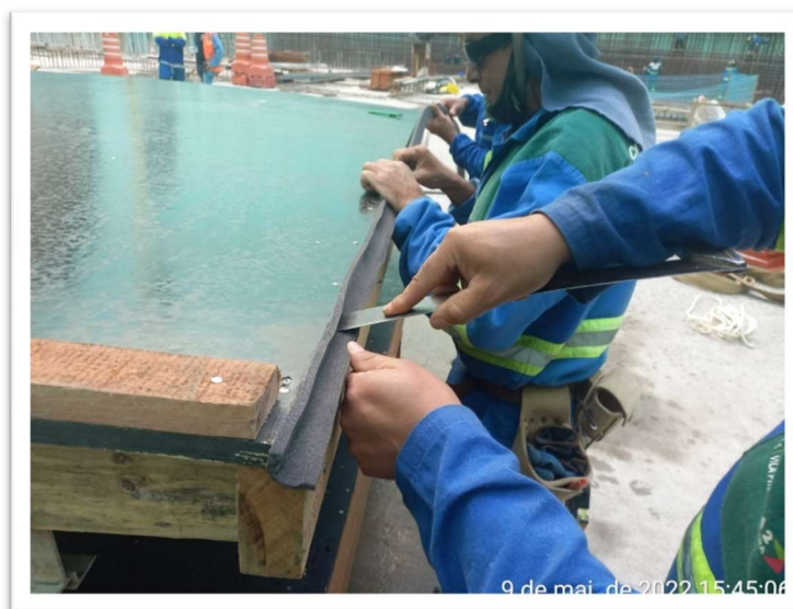
Foto 3 – Colocação da fita adesiva de espuma – Estação Vila Formosa
