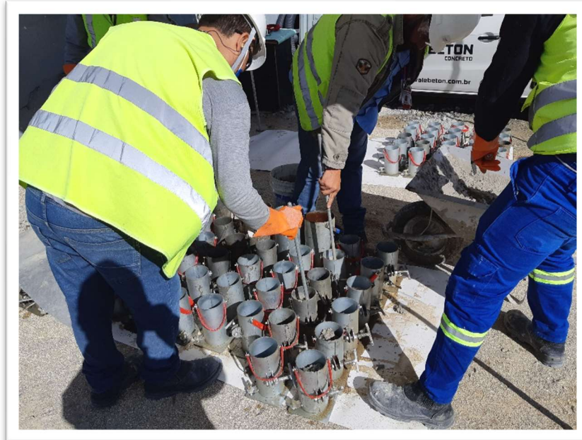
Foto 9 – Moldagem de corpos de prova - Estação Vila Formosa
