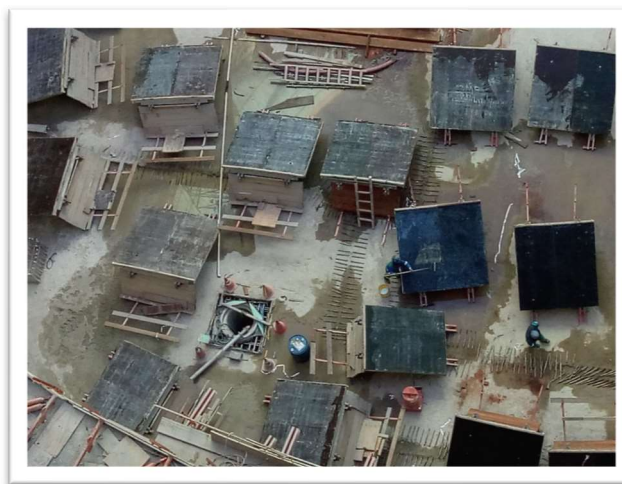
Foto 10 – Praça de trabalho para reforma de painéis
