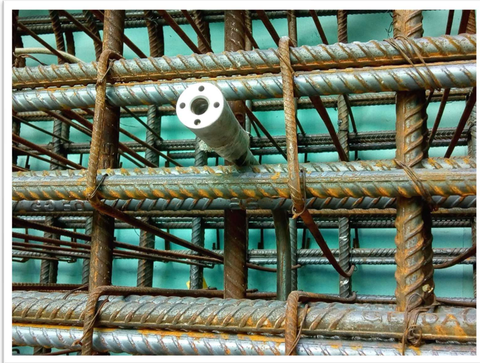
Foto 13 – Cone metálico (recuperável) de ancoragem posicionado dentro da armação, para futura ancoragem das fôrmas
