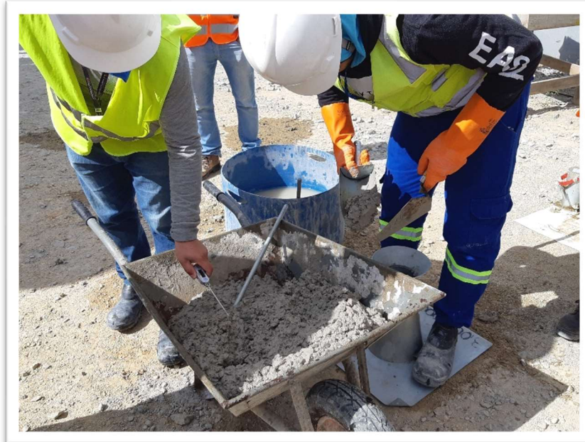
Foto 8 – Medição de temperatura do concreto - Estação Vila Formosa
