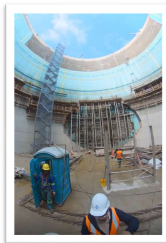
Fotos 15 e 16 – Fôrmas e cimbramentos na região dos emboques dos túneis
