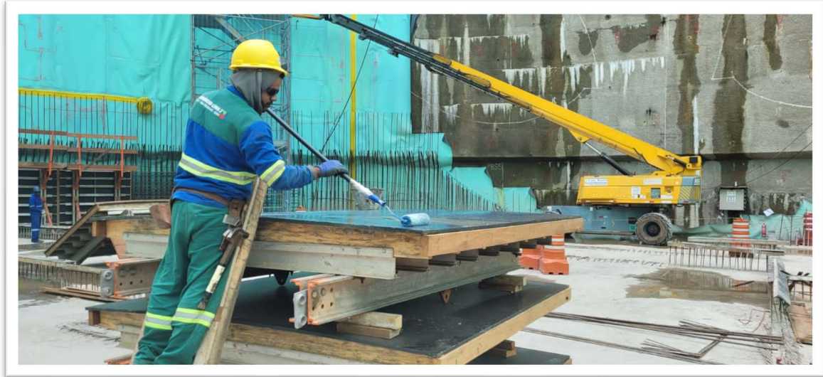
Foto 11 – Aplicação do desmoldante a fôrma
