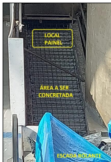
Figura 7 – Laje a ser concretada para montagem do painel da escada rolante
