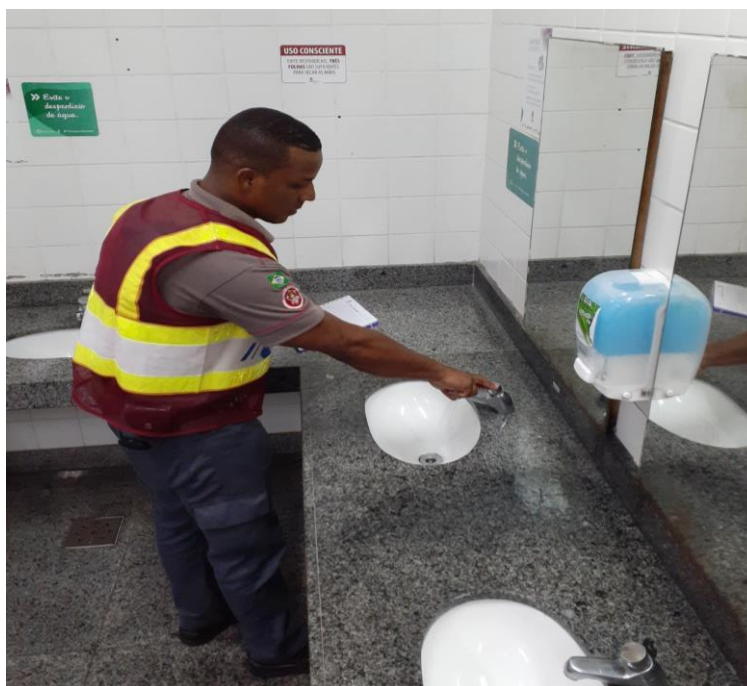
Figura 12 – Agente de Atendimento verificando o funcionamento dos equipamentos hidráulicos (Fonte: Autor)
