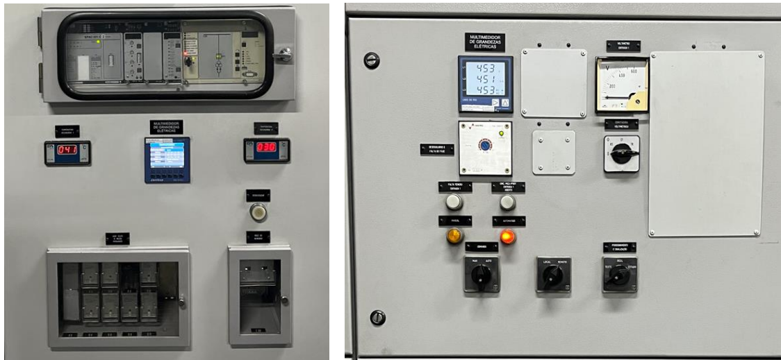
Figura 13 – Exemplo de uma modernização de multimedidor onde foi substituído o antigo eletromecânico e instalado um novo, com o correto fechamento do vão existente com chaparia específica para painel elétrico
