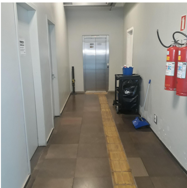
Figura 9 – Acesso ao elevador onde antes era área restrita (foto do autor)
